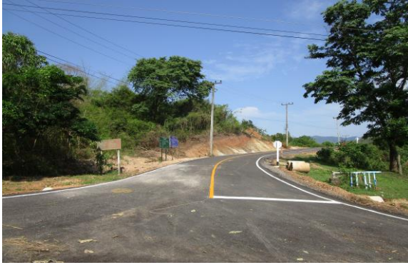
โครงการก่อสร้างถนนลาดยางสายห้วยน้ำหนัก-ห้วยผาก ม.๖
