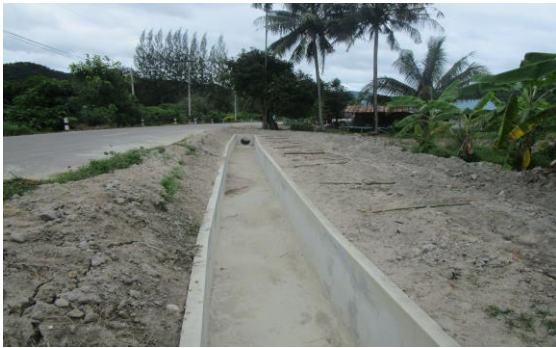
โครงการก่อสร้างรางระบายน้ำรูปตัวยูบ้านป่อเก้าบน ม.๗
