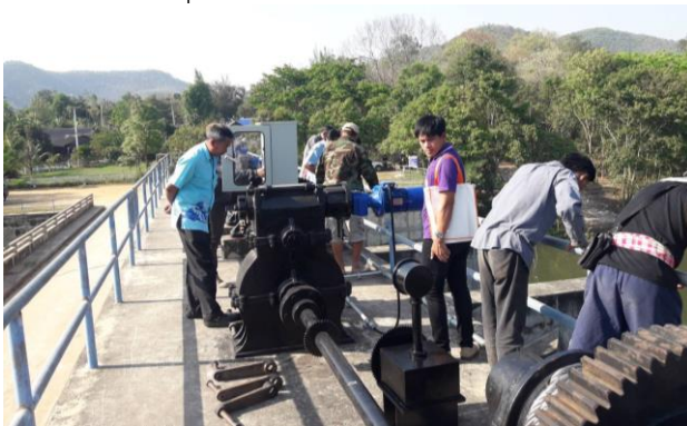
โครงการขุดเจาะบ่อน้ำบาดาลบ้านห้วยแห้ง ม.๕
